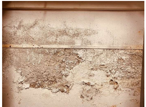
Fot. Strefa „A”. Archiwum stałe. Obraz rozległych wysoleń i korozji biologicznej ściany zewnętrznej. Wysokość powyżej 1,5m.
