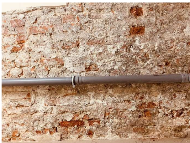
Fot. Strefa „B”. Ściana zew. przy wiatrołapie. Ogólny obraz wysoleń i degradacji przypowierzchniowej cegły.
