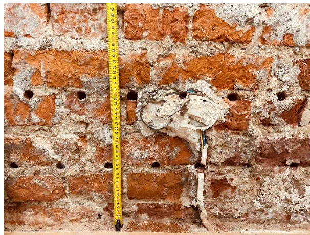
Fot. Strefa „B”. Archiwum stałe. Obraz odcinka próbnej iniekcyjnej izolacji poziomej funkcjonującej poprawnie.
