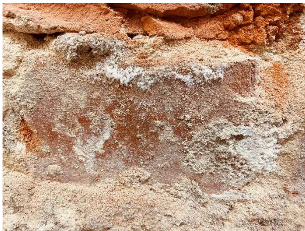
Fot. Strefa „B”. Archiwum stałe. Widoczne wysolenia cegły ściany zewnętrznej.
