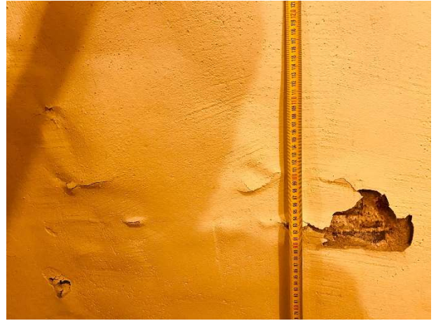
Fot. Strefa „A”. Węzeł cieplny. Zawilgocenia i degradacja malatury i tynków do wysokości ok. 1,0m.
