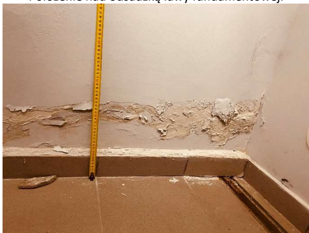
Fot. Strefa „A”. Archiwum przesuwne. Zawilgocenia muru zewnętrznego. Degradacja tynku i malatury.
