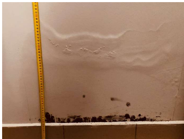
Fot. Strefa „A”. Archiwum przesuwne. Zawilgocenia muru zewnętrznego. Degradacja tynku i malatury do wysokości ok. 40cm.
