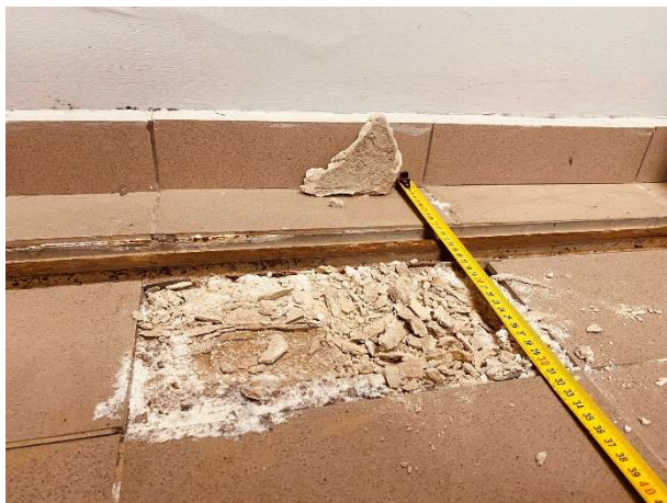
Fot. Strefa „A”. Archiwum przesuwne. Lokalnie występująca wilgoć pod powierzchnią posadzki. Położenie nad odsadzką ławy fundamentowej.
