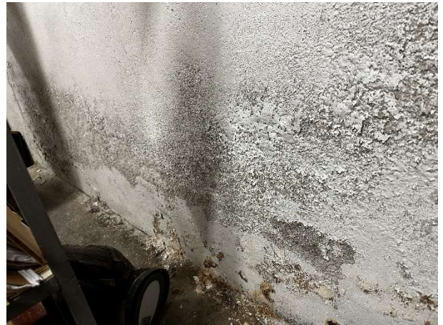
Fot. Strefa „A”. Archiwum stałe. Obraz rozległych wysoleń i korozji biologicznej ściany zewnętrznej.
