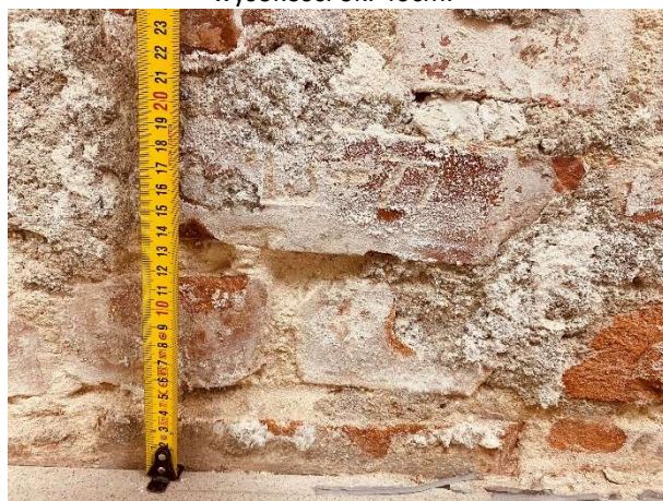
Fot. Strefa „B”. Archiwum stałe. Obraz odkrytego muru. Degradacja przypowierzchniowej warstwy cegły. Widoczne wysolenia i korozja biologiczna.
