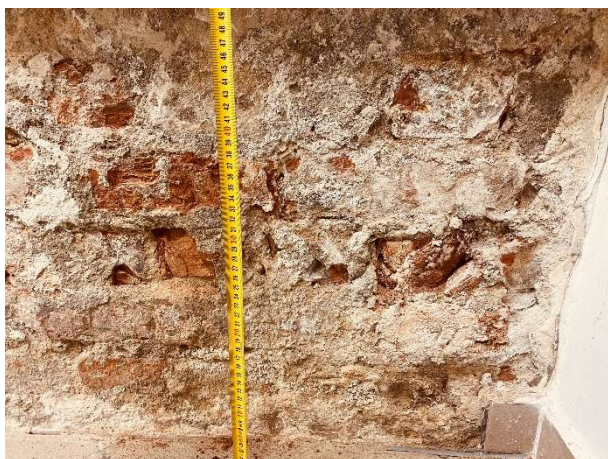
Fot. Strefa „B”. Archiwum stałe. Obraz odkrytego muru. Degradacja przypowierzchniowej warstwy cegły.
