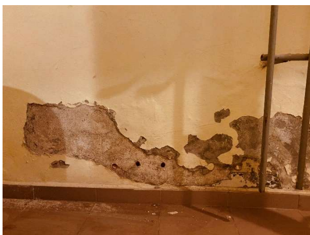
Fot. Strefa „A”. Węzeł cieplny. Zawilgocenia i degradacja malatury i tynków.
