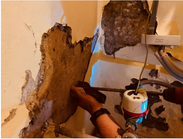
Fot. Strefa „A”. Węzeł cieplny. Zawilgocenia i degradacja malatury i tynków. Miejsce poboru próbek.
