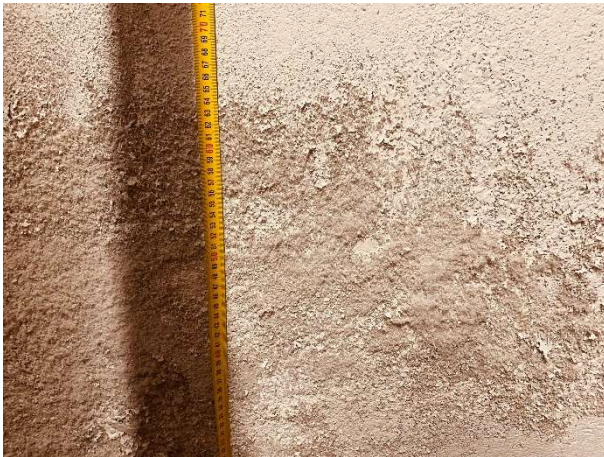
Fot. Strefa „A”. Archiwum stałe. Wysolenia i korozja biologiczna w wyniku wysokiej wilgotności do wysokości ok. 80cm.
